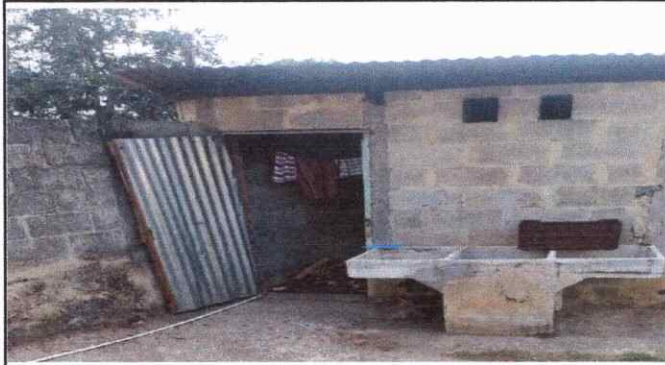
Foto1: Rehabilitación de la cocina del centro educativo
