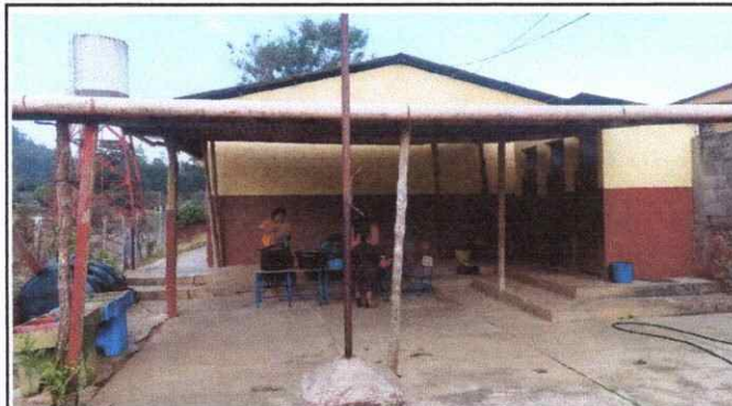
Foto 3: Sustitución de lámina del corredor del centro educativo
