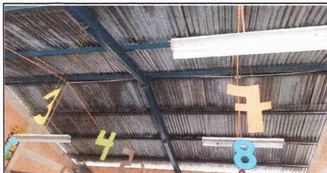
Foto 5: Cambio del sistema eléctrico del centro educativo
