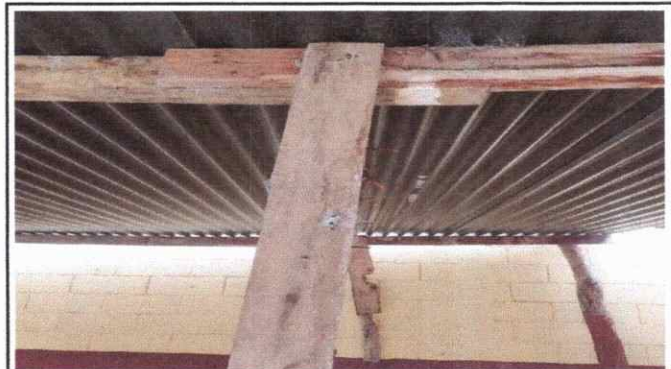
Foto 4: Sustitución de lámina, por lámina troquelada aluzinc calibre 26
